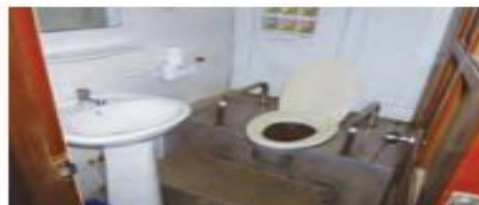
観光船内に設置したバイオトイレ (SW-43型)
