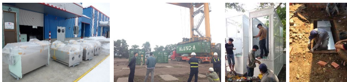
バイオトイレ・新浄化措置の導入・設置の様子
